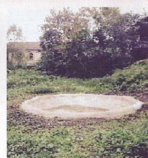
NARDON Bassin non réhabilité ACRECF 2017
