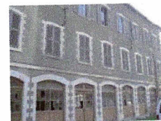
Vue de la façade est
