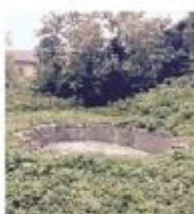
NARDON Bassin en cours de restauration ACRECF 2016
