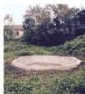
NARDON Bassin non réhabilité ACRECF 2017
