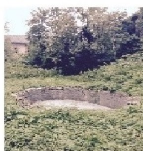
NARDON Bassin en cours de restauration ACRECF 2016
