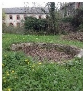
REVEX FORGES Bassin avant restauration CERFAC 1987 - 2015
