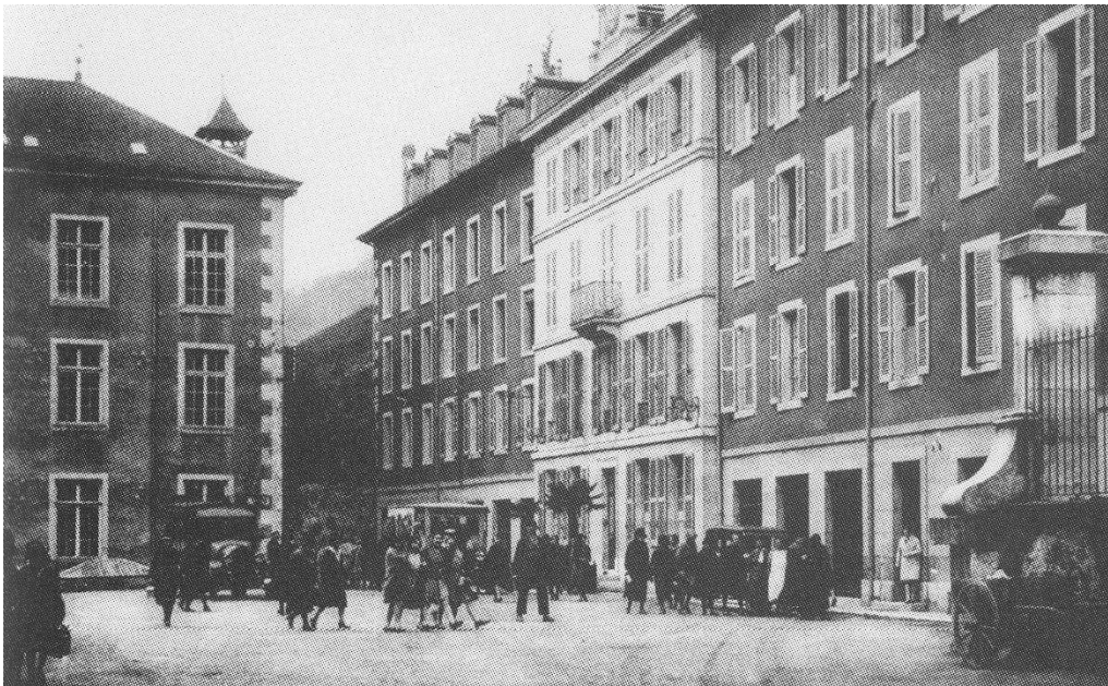
Figure 47 : Carte postale montrant le bâtiment détruit dans les années 1970 (source : Gilles Michel)
