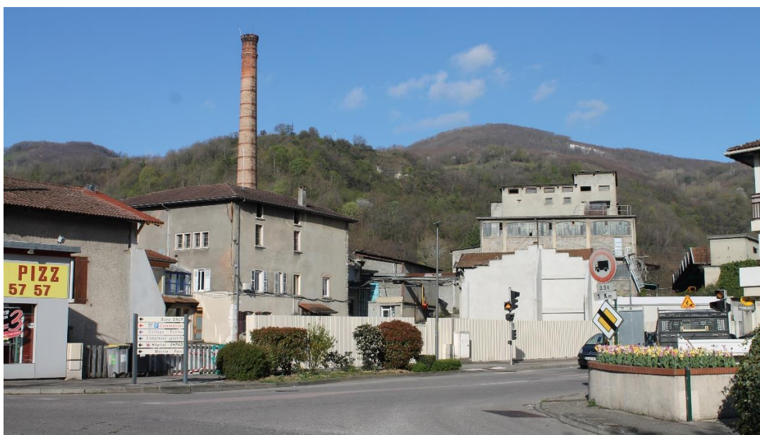
Figure 38 : Vue depuis le carrefour sur la cheminée et le terrain libéré
