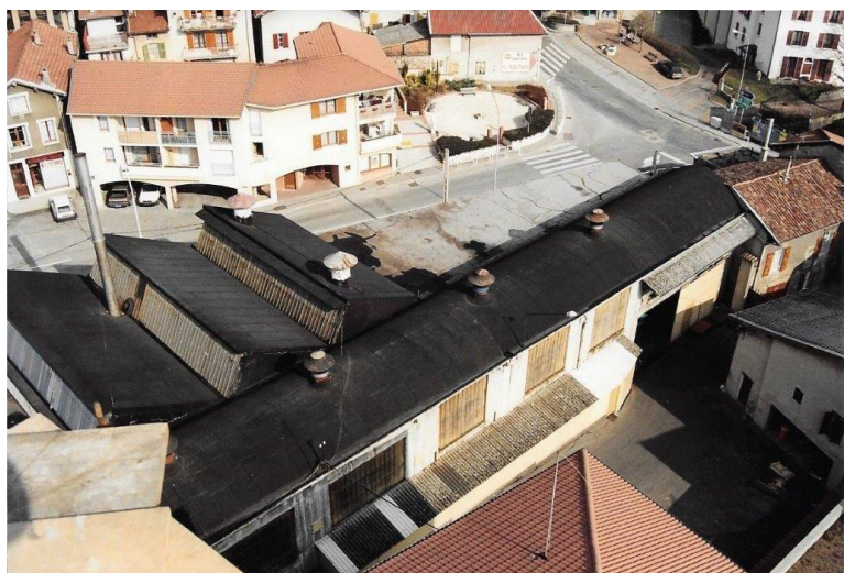
Figure 18 : Halle de la machine à papier et sheds (source : association Mémoire et Patrimoine de Fures et de Tullins)
