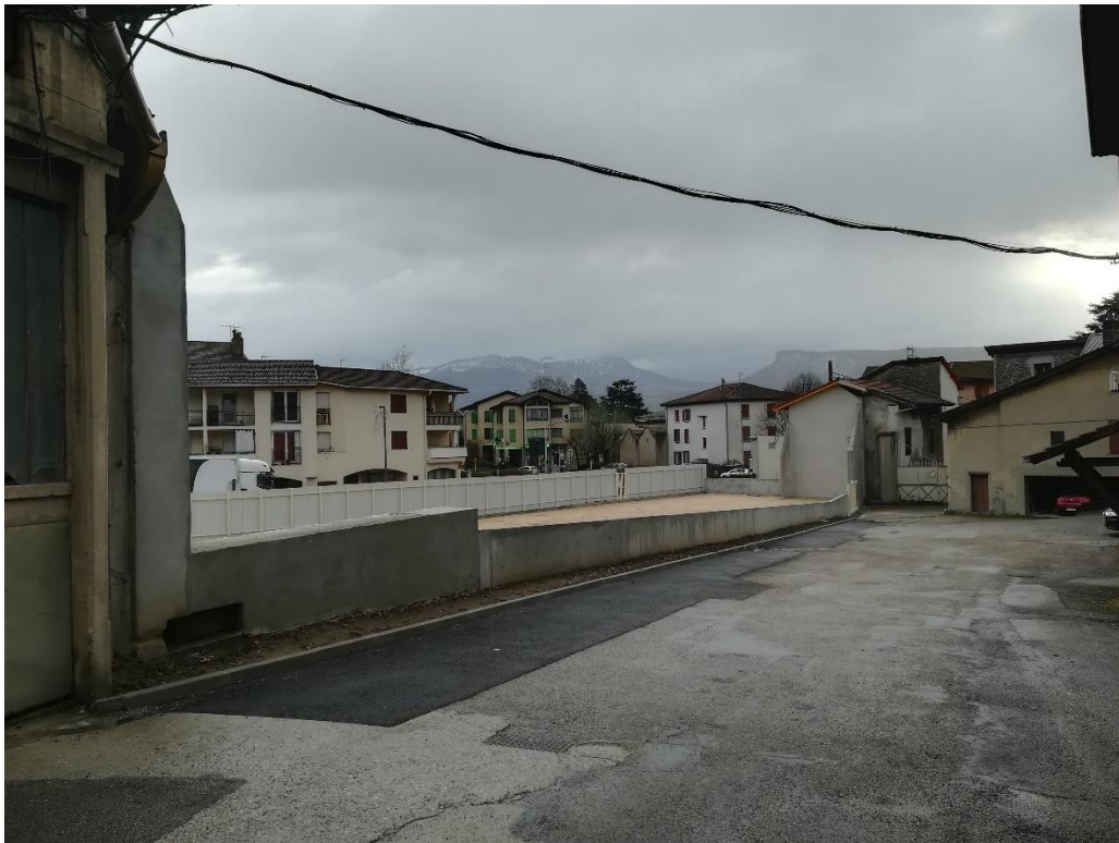
Figure 37 : Vue depuis l'intérieur du site après la démolition
