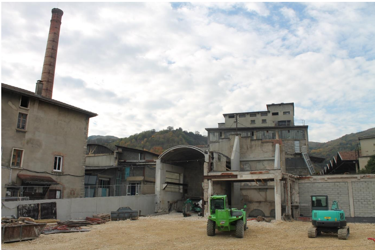
Figure 35 : Site durant la démolition de la halle et d'une partie des sheds
